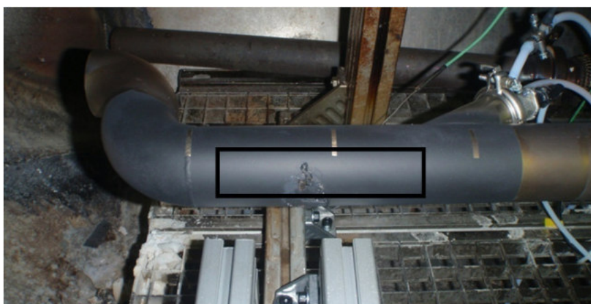
(b) Prüfstands Aufbau
