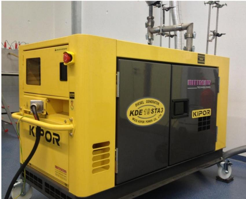
**Abbildung 8:** Diesel-Stromgenerator zur Verrußung der Katalysator-Wabenkörper.
